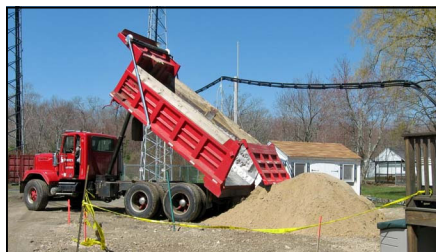
A LOAD OF SAND FILL
